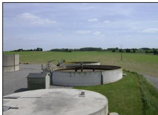
Installation de traitement
