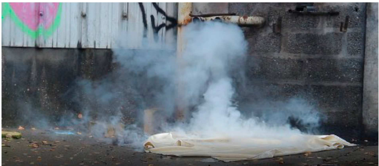
Vapeurs d'électrolyte inflammables suite à inertage de la batterie © Nicolas Chantreuil – SDIS 73
