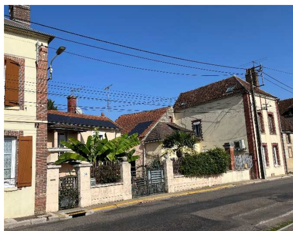
Réseau basse tension
