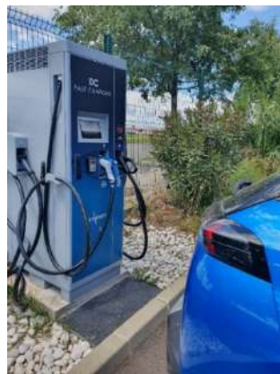
Borne recharge KEYWATT® 50kW - charge à destination ou en itinérance © IES Synergy
