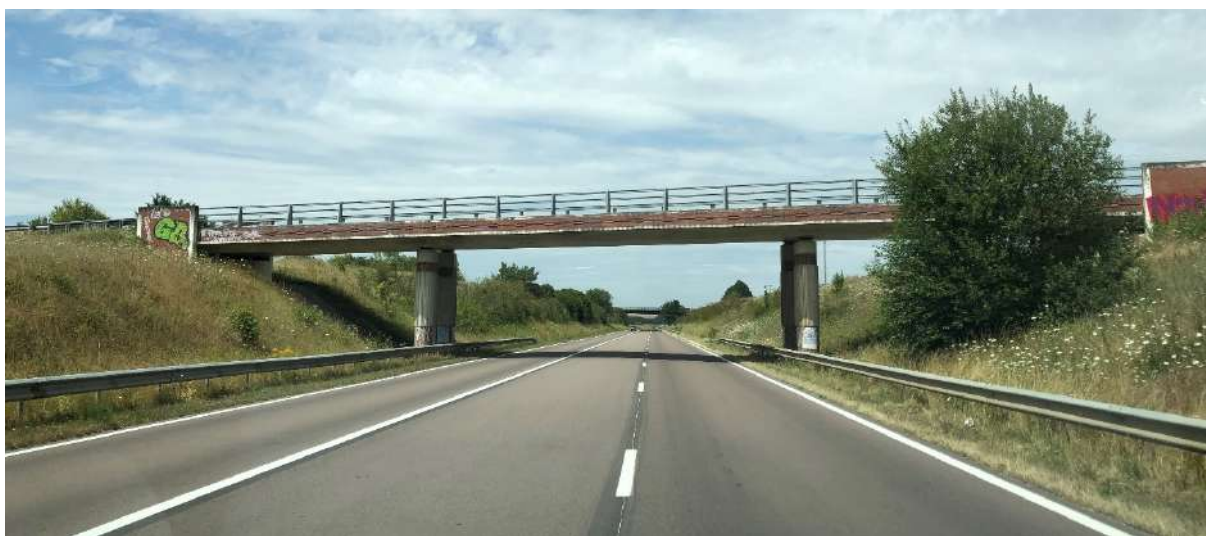
Pont à poutres © Djamel Ferrand - DGSCGC
