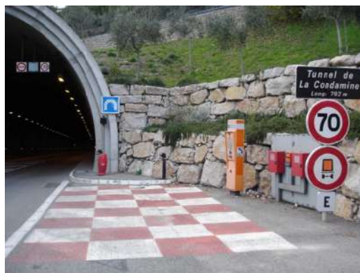
Aire de stationnement pour les véhicules de secours
