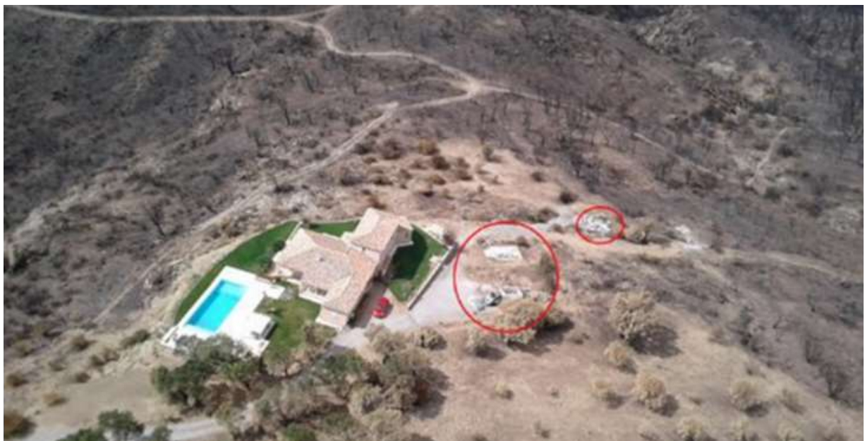
Entourées en rouge, les structures qui ont brûlé en l'absence de débroussaillage à proximité © SDIS 83
