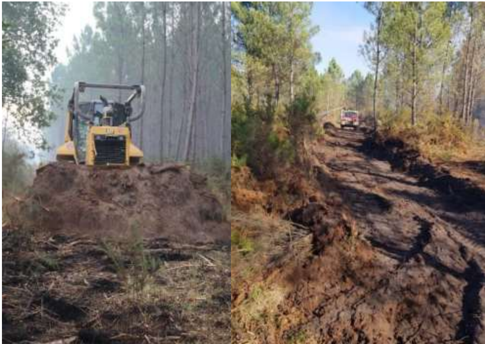
Travail de terrassement - Bande périmétrale – Rupture du combustible tourbeux © SDIS 33
