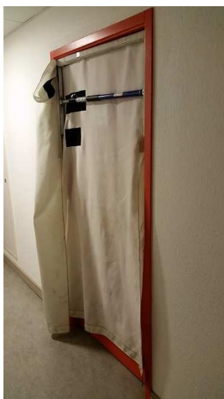
Illustration n°1 : installation d'un « stoppeur de fumées »
