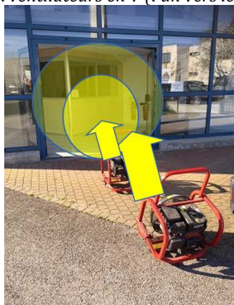
Illustration n°5 : Utilisation de deux ventilateurs l'un derrière l'autre
