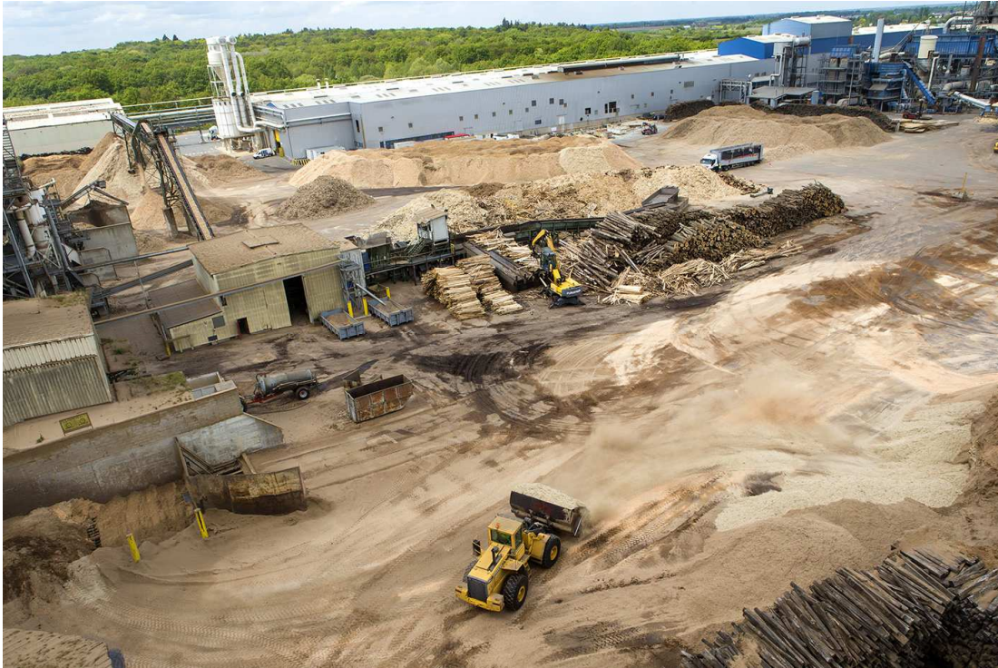
Unité de transformation de bois
